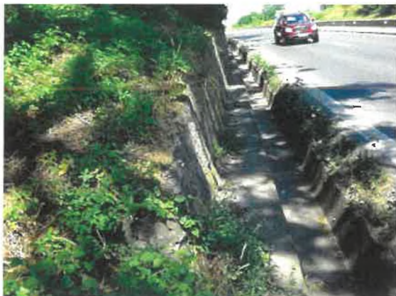
Foto 8. Vedere spre Iia. Zid de sprijin pe p. stg. DN 7
